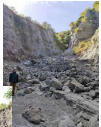
壁が崩れて、階段状を作成し (2024)
